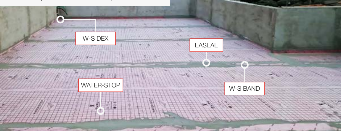
Impermeabilización de capa fina en terraza
